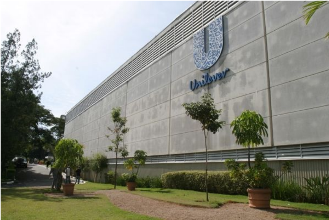
Imagem 5: Fachada da Unilever em Vinhedo (SP)
