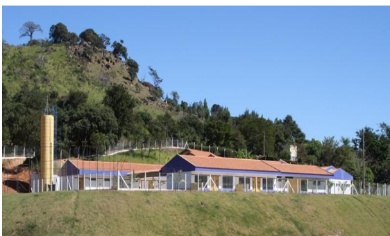
FIGURA 1 – Creche e Pré-escola Maria Dalva Tomé de Araújo localizada na cidade de São Sebastião da Grama – SP
