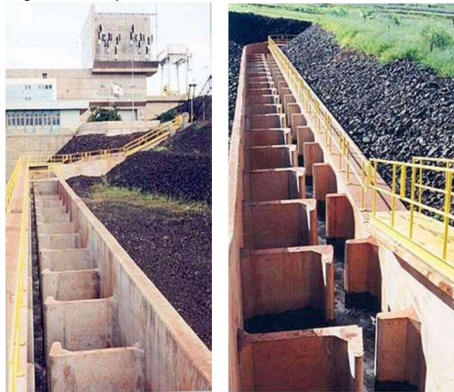
Figura3. Escada tipo ranhura vertical
