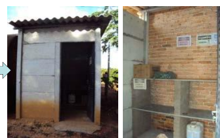
Depósito guarda de agrotóxicos
