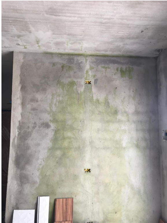
Figura 3 – Foto do interior obra estudada localizada no bairro Portal dos Lagos em Aguaí, São Paulo (-22°05'40.27"S -46°99'08.32"W; -22.05402191028803,-46.990844922255434 - (Fonte: Próprio autor).
