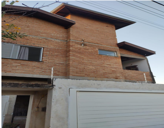
Figura 5 - Fotografia da fachada frontal. (Fonte: Autoria própria)
