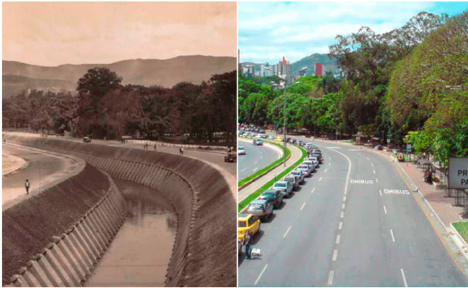
Imagem 7 – exemplo de canalização de rio.
