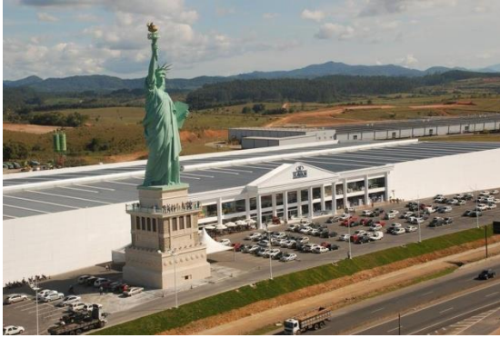
Figura 62: Loja de departamento HAVAN (Fonte: Foto retirada do Google, 2017)
